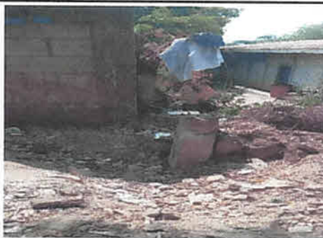
Foto 6: construyendo el muro perimetral
