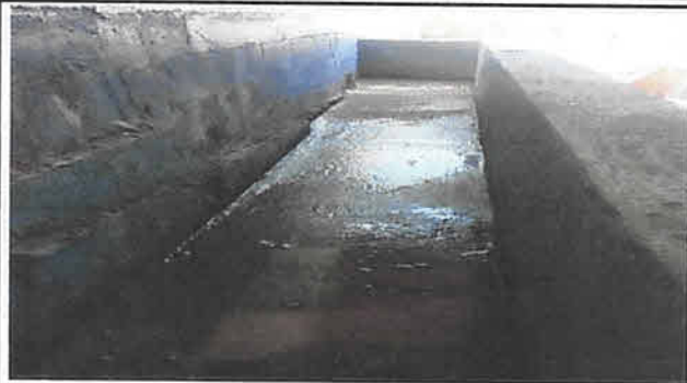
Foto 1: inicio con reparación de cuneta de concreto
