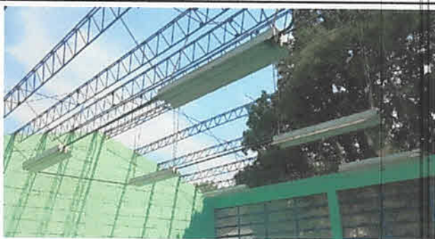
Foto 4: anclaje de costaneras de metal sobre jois
