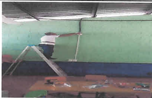
Foto 5: Instalación de energía eléctrica
