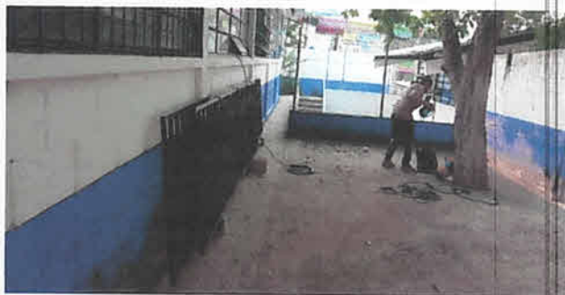
Foto 2: reparando la baranda de metal
